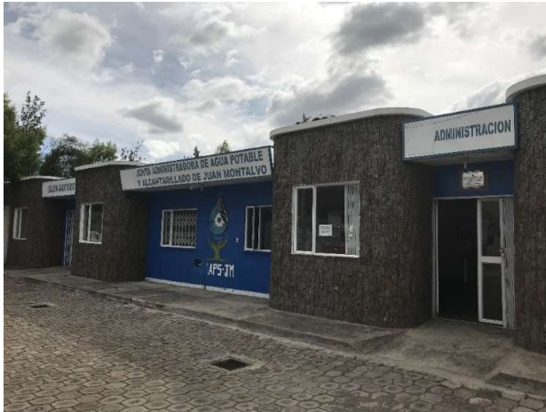
Ilustración 10. Instalaciones y oficinas propias de la JAAPyS Juan Montalvo. Fuente: Archivo propio, 2018.
