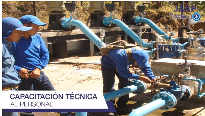
Ilustración 5. Capacitación técnica a los operadores por parte de la EPMAPS Quito. Fuente: JAAPT, 2018.
