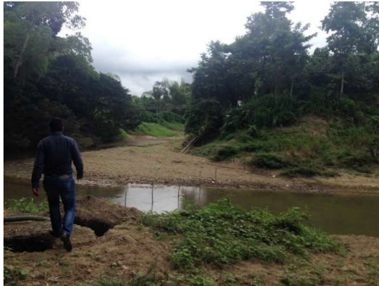
Ilustración 22. Captación desde el Río Jama. Fuente: Archivo propio, 2017.
