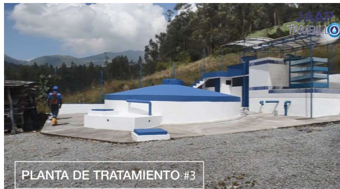
Ilustración 8. Planta de Tratamiento 3 de la JAAPT. Fuente: JAAPT, 2018.
