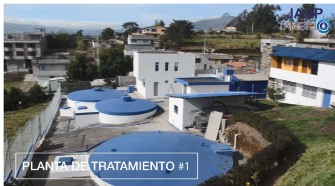
Ilustración 6. Planta de Tratamiento 1 de la JAAPT. Fuente: JAAPT, 2018.
