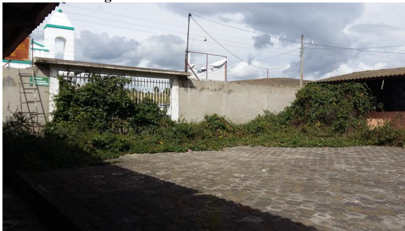
Fotografía 46. Fachada Interna de la escuela
