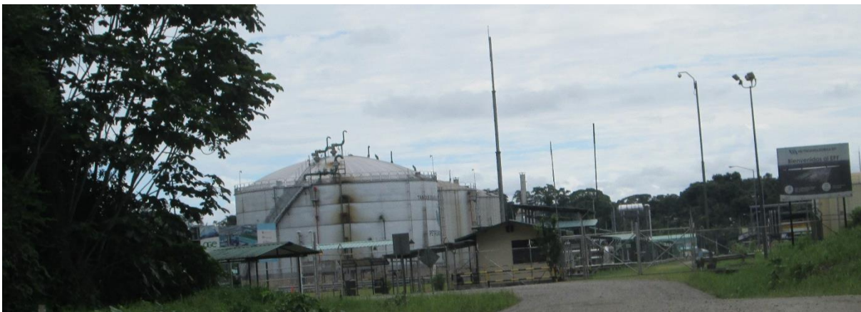
Figura 3.8. Entrada EFP del campo unificado Edén Yuturi, bloque 12
