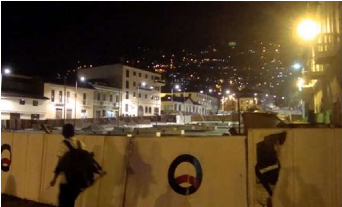
Ilustración 19. Obras Av. 24 de Mayo
