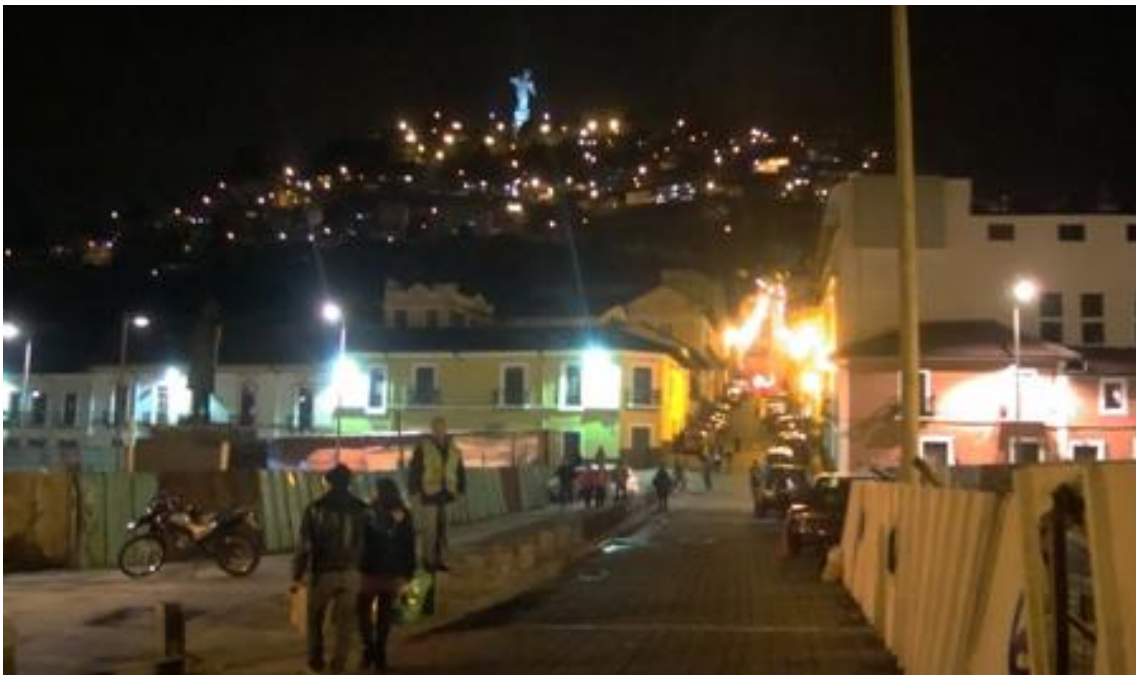
Ilustración 21. Parquederos y obras de rehabilitación Av. 24 de Mayo
